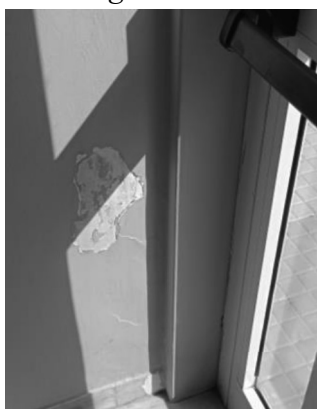
Uscita dal vano scala
